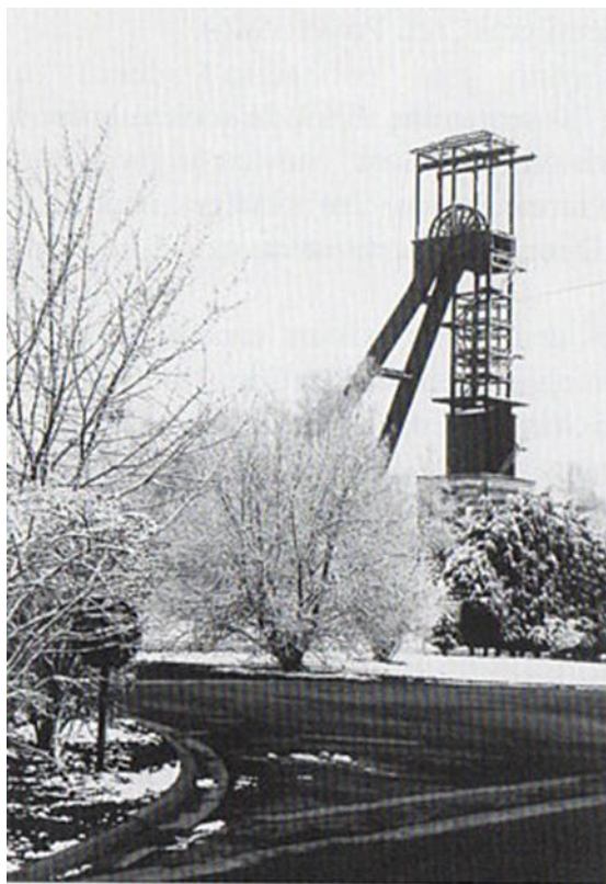
Châssis à molettes du puits n° 2 à Anderlues. Photo: G. Paridaens, 1999.
